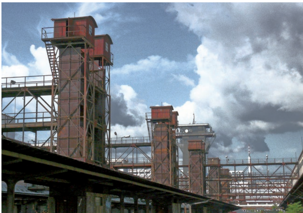
Rekonstrukcí projdou i památkově chráněné výtahové věže
